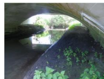
Passages de la Scheer sous la route D1083 et la voie ferrée avec présence de banquettes.
